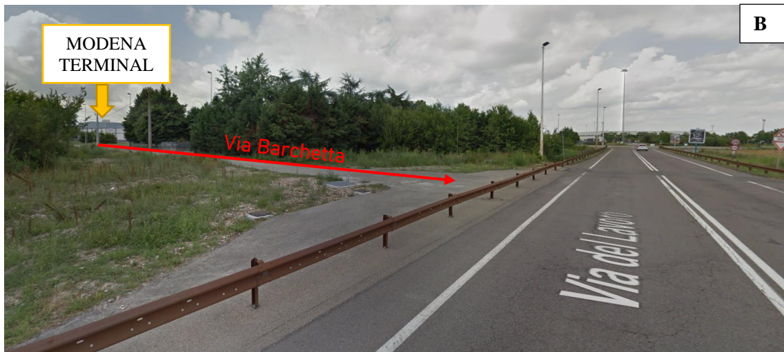
Figura 4 - (A) - Vista di via Barchetta verso via del Lavoro (B) - Intersezione non compiuta di via Barchetta con via del Lavoro
